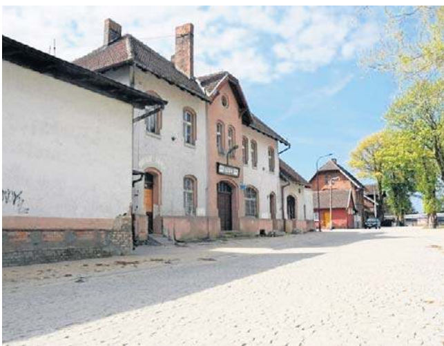
Otoczenie dworca w Łebie zostało wyremontowane ale budynek dworca to rudera. Gmina Łeba go nie przejmie
