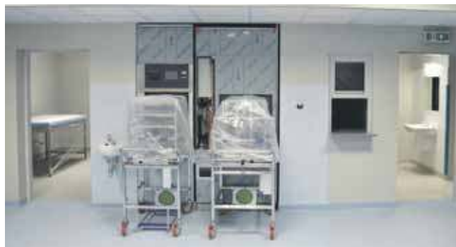
Trwają prace wykończeniowe
