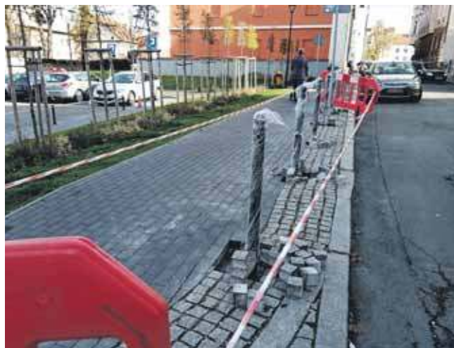
Przy ul. Opolskiej zamontowano rząd słupków
