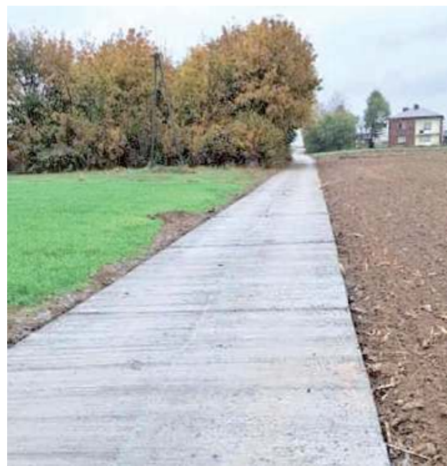
Betonowa droga w Czerniecinie Głównym ma wytrzymać nawet pół wieku
