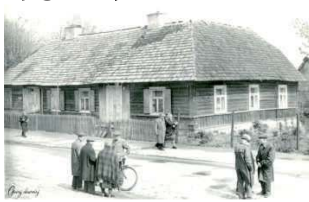
Plebania w Goraju z około 1890 roku. Została wyburzona w maju 1974 roku, gdy proboszczem był ks. Jan Łatka, a wikariuszem ks. Janusz Romańczuk. Zdjęcie wykonano niedługo przed rozbiórką. Na jej miejscu wybudowano dzisiejszą plebanię
