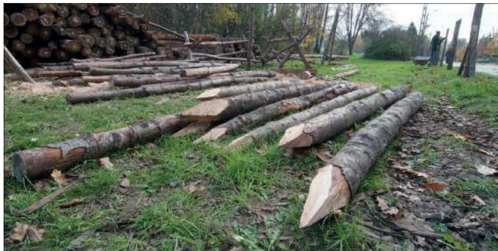
Okorowywanie drewnianych bali wymaga wprawy, siły i wytrwałości. Pozbawione kory drzewo zostanie zaimpregnowane, zastrzone, a następnie użyte do budowy palisady.
