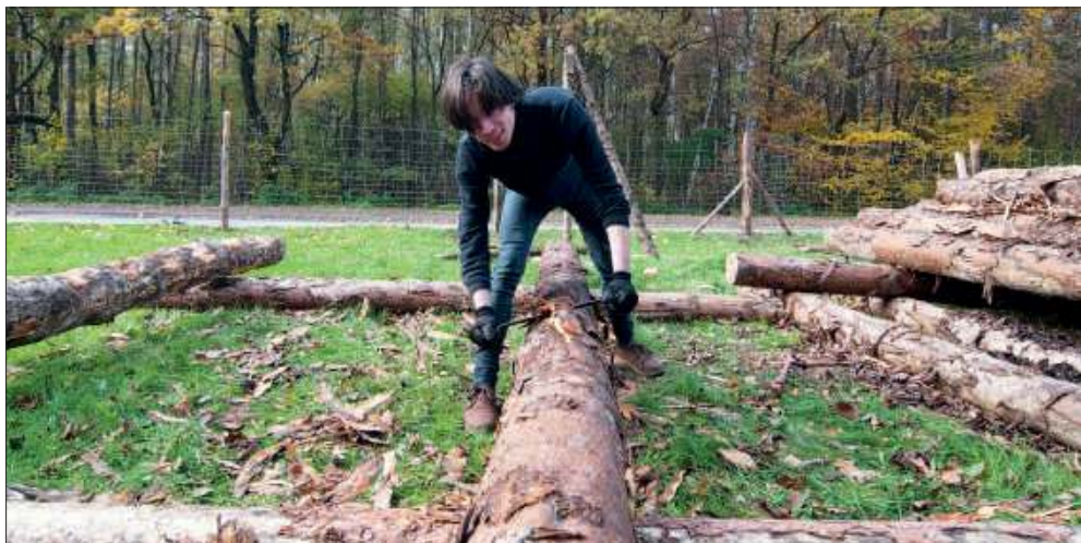
Okorowywanie drewnianych bali wymaga wprawy, siły i wytrwałości. Pozbawione kory drzewo zostanie zaimpregnowane, zastrzone, a następnie użyte do budowy palisady.
