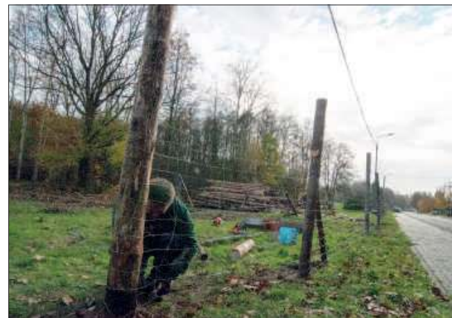
Na czas trwania budowy drengowie postanowili ogrodzić cały teren
