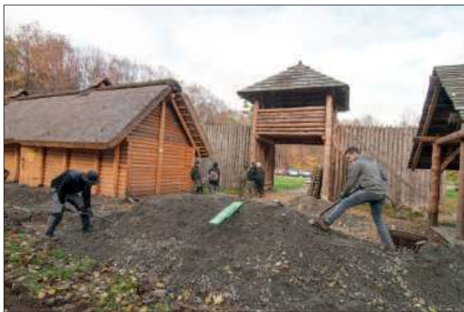
Wojowie rozplantowują żwir, który posłuży do utwardzenia terenu grodziska
