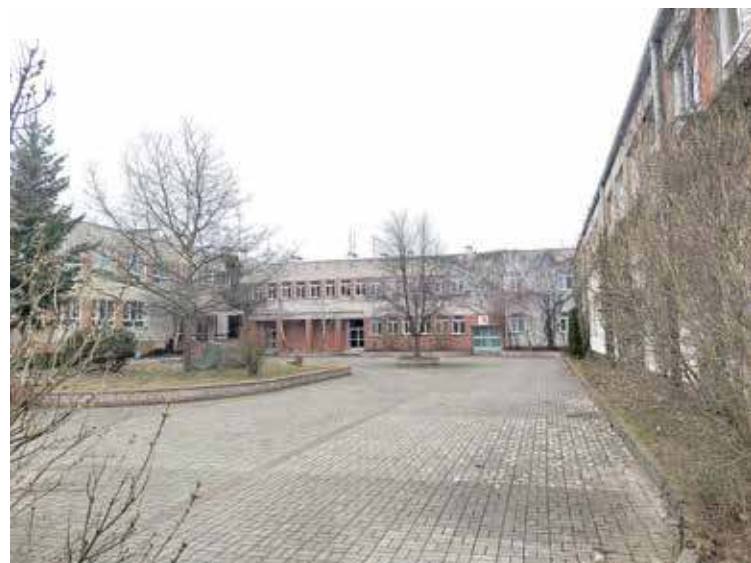
Jedyny z planowanych schronów miał się znaleźć w piwnicy II LO w Nowogardzie
