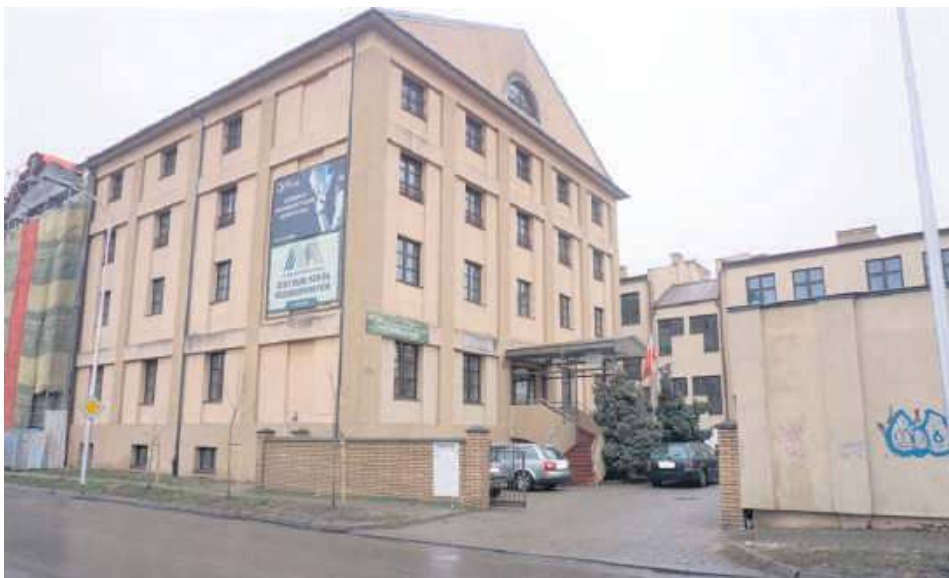
Budynek przy ul. Sienkiewicza 22 jest w dobrym stanie technicznym, ale jakiś retusz na pewno zostanie do jesieni przeprowadzony.
