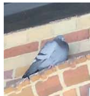
Gołębie siadają na gzymsach i pod wiatą na peronie
