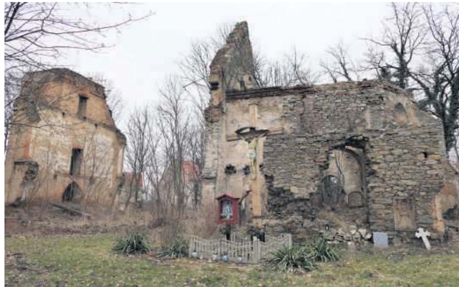
Gmina Wiązów stara się o dofinansowanie na zabezpieczenie ruin kościoła ewangelickiego w Miechowicach Oławskich
