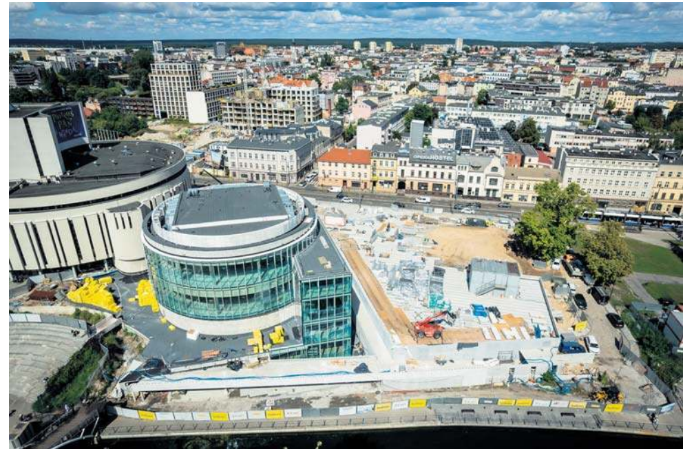
Budowa czwartego kręgu Opery Nova, fot. Tomasz Czachorowski/eventphoto.com.pl dla UMWKP
