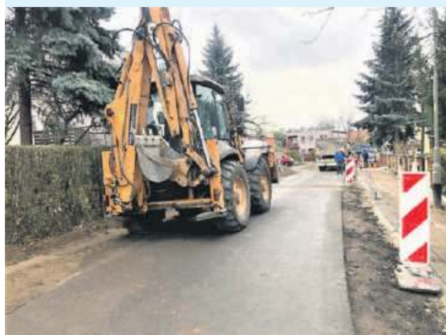
Kanalizacja deszczowa oraz chodnik na ulicy Okólnej
