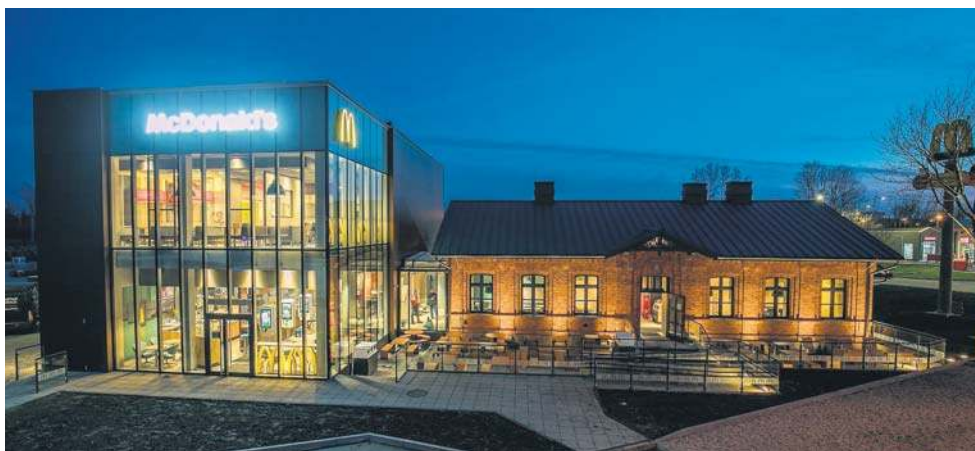
Restauracja McDonald's, ul. Radzymińska 94A w Warszawie
