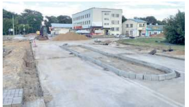
Trwa budowa ronda przy Urzędzie Skarbowym w Radzynie. Podczas ostatniej sesji Rady Miasta radni zdecydowali o wsparciu finansowym powiatu radzyńskiego kwotą 64,5 tys. zł na ten cel. Zadanie obejmuje przebudowę odcinka drogi powiatowej (to 10 proc. planowanej inwestycji).
