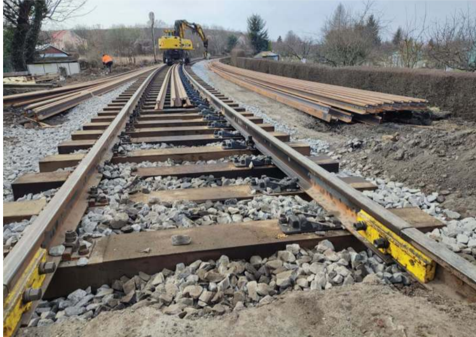
Na odcinku od ul. Borowskiej w kierunku Mikoszowa jest już położonych kilkaset metrów nowych szyn
