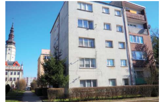
Blok przy ul. Książąt Brzeskich w Strzelinie
