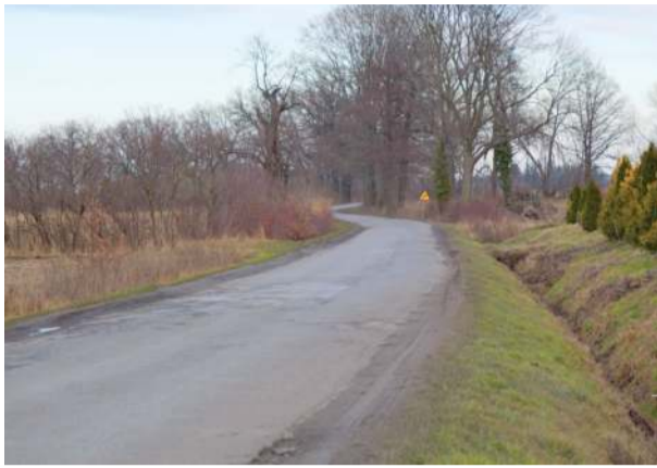
Droga relacji Prusy – Gołostowice zostanie przebudowana
