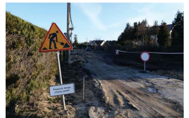
Z początkiem marca wznowiono prace związane z przebudową ul. Polnej w Wiązowie
