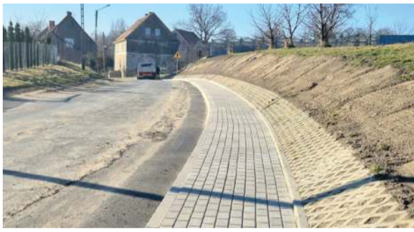
Zakończyły się prace przy budowie chodnika w Żelowicach. Fot. UG w Kondratowicach
