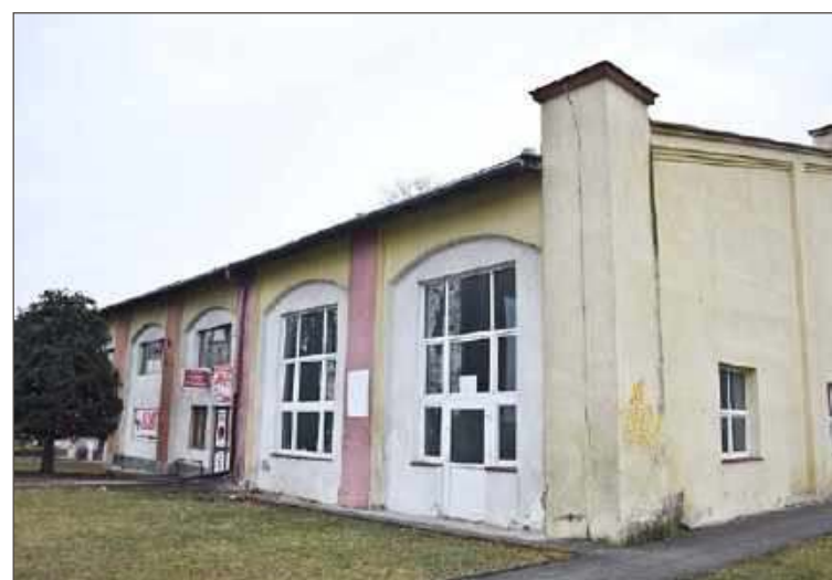
Hal przy ul. Kościuszki będzie remontowana.
