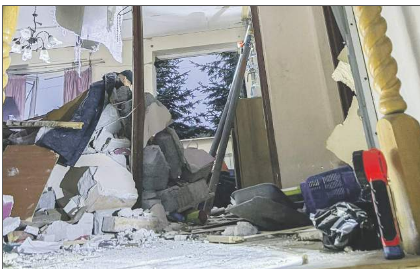
■ Pieniądze ze zbiórki zostaną przeznaczone na odbudowę zniszczonego domu
