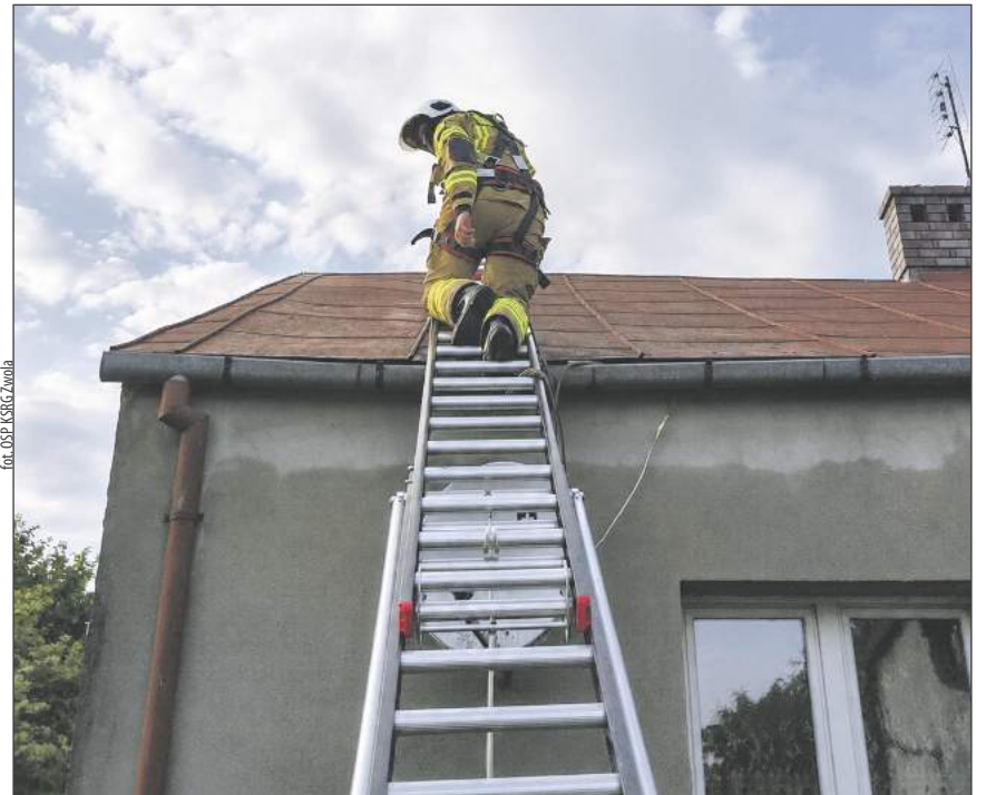
Akcja przy zerwanym poszyciu dachowym w Brzegach (fot. OSP KSRG Zwola)
