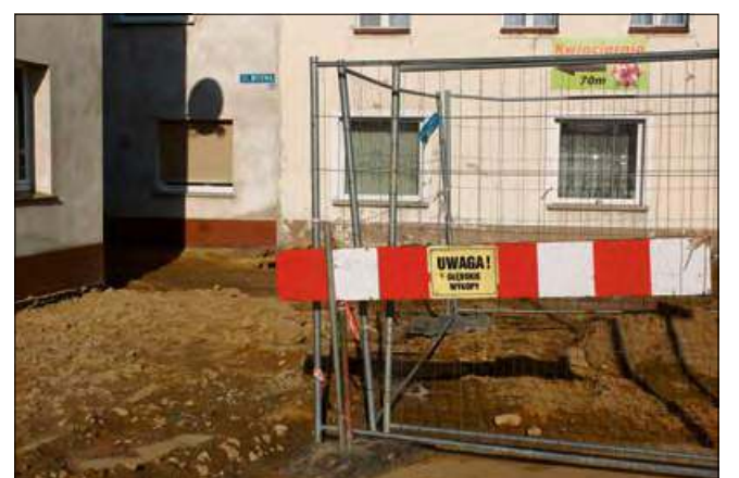
Postęp prac widać gołym okiem.
