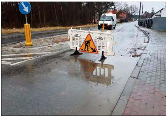
Aby usunąć awarię, trzeba było rozkopać drogę.
