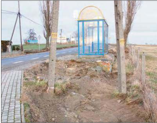
Drogowcy zaczęli prace przygotowawcze na skrzyżowaniu w Kórnicy.
