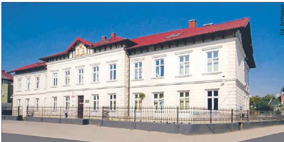
Kompleks sądowy w Mielcu zostanie przebudowany. Zmieni się też jego otoczenie, a całość prac ma zostać wykonana w 36 miesięcy.
