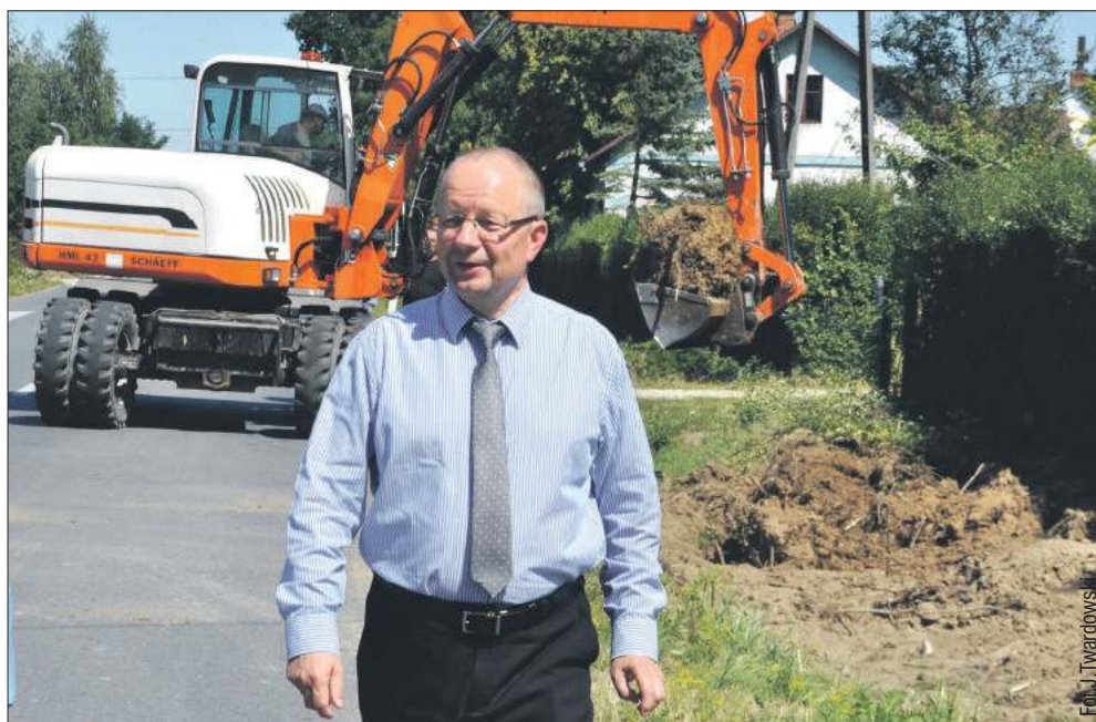
Stanisław Mieszkowski, wójt Borowej, przebudowuje i remontuje drogi w całej gminie. W centrum Borowej przebudowano już 70 proc. dróg, w tym gruntowych, pozostałe 30 proc. powinno zostać przebudowane najpóźniej w przyszłym roku.
