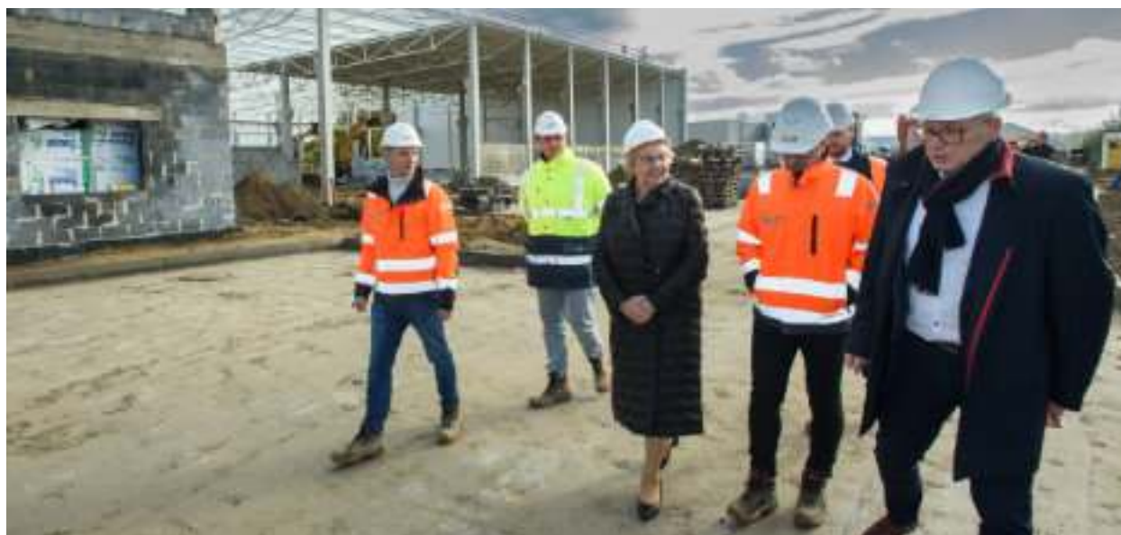
► Prezydent Zabrza Małgorzata Mańka-Szulik z przedstawicielami inwestora na placu budowy jednego z obiektów Fot. UM Zabrze
