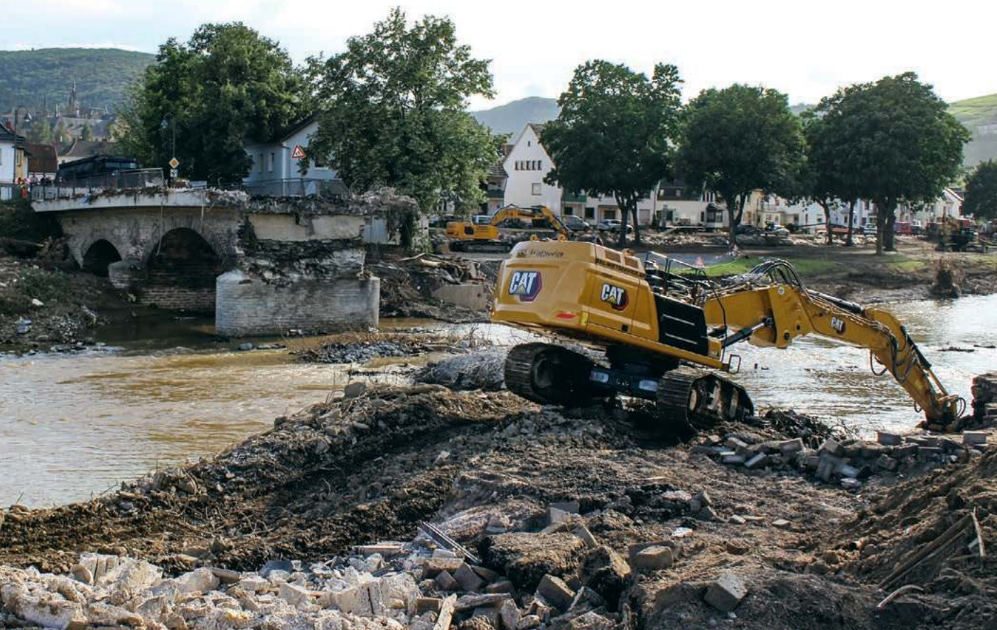
Miasteczko Ahrweiler po powodzi, widoczny zniszczony most, 25 lipca 2021 r.
