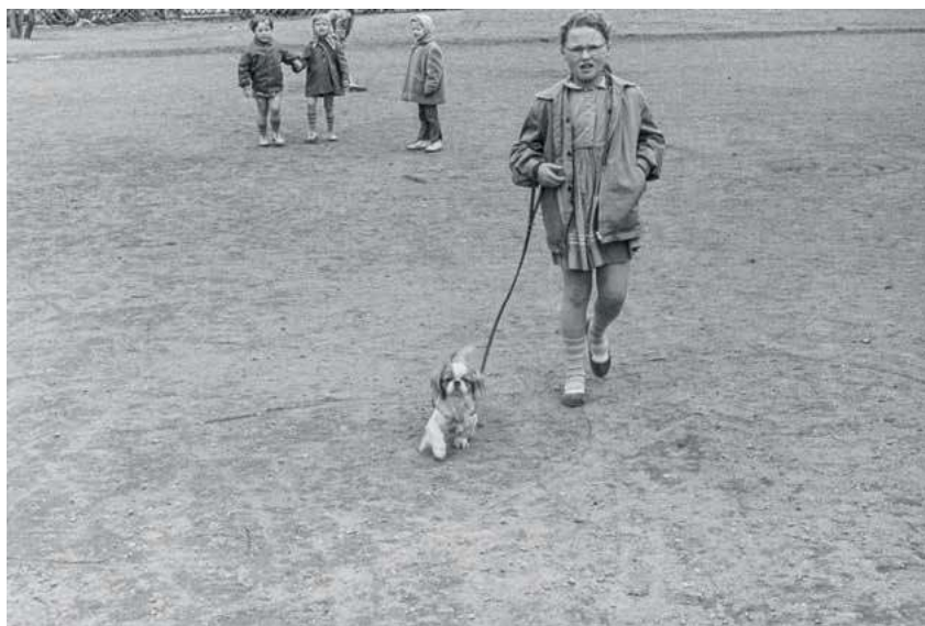
Podwórko na tyłach budynku przy ul. Świętokrzyskiej 18a w Warszawie, lata 1954–1967
