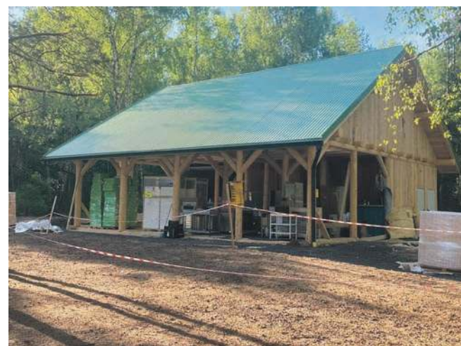
Tak wygląda budynek przyszłej restauracji nad Balatonem
