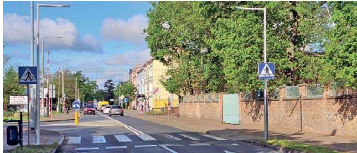
Doświetlone zostało przejście przy ruchliwej ulicy Wojska Polskiego
