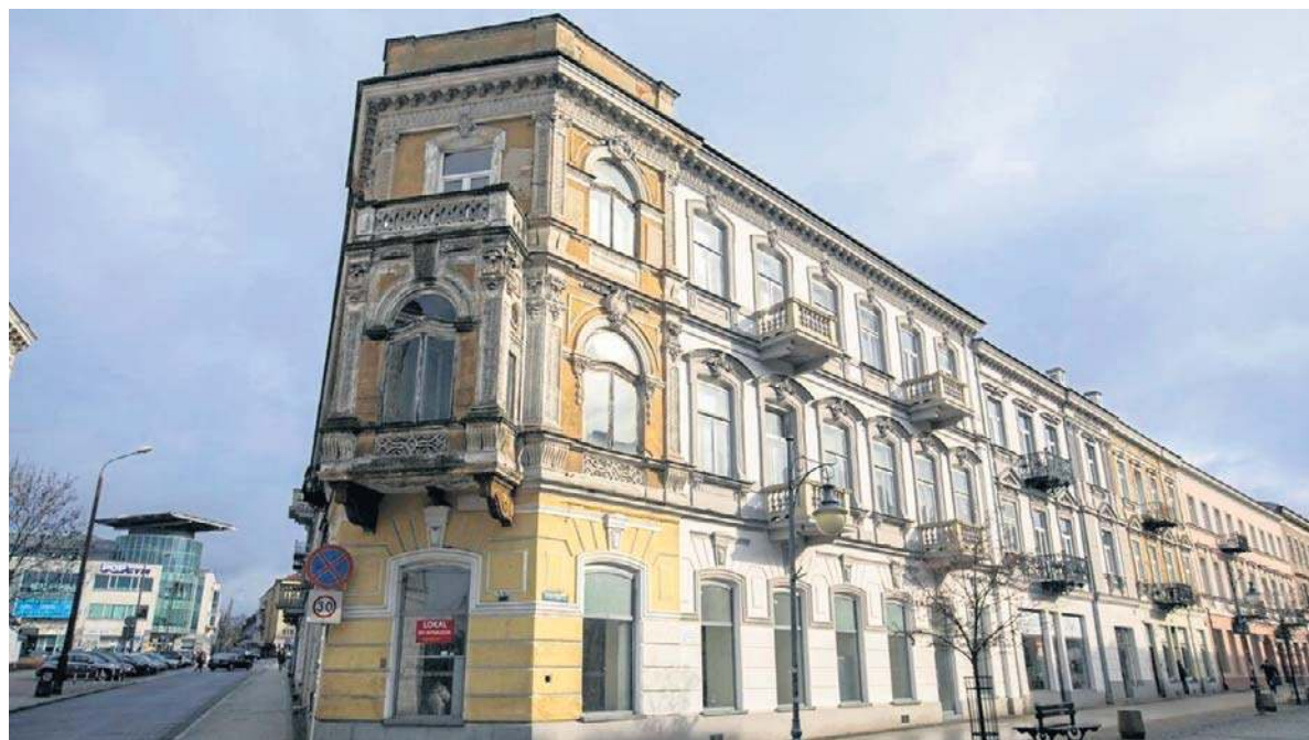
Na remont elewacji czeka między innymi przepiękna kamienica przy ulicy Witolda 2.
