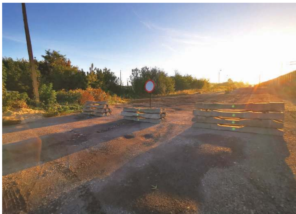
Betonowe zapory blokują wjazd i wyjazd
