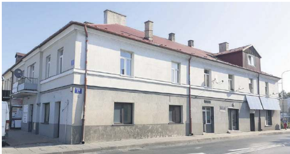
Kamienica z zewnątrz odnowiona, w środku...
