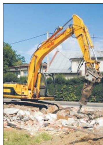
Budynek został wyburzony.
