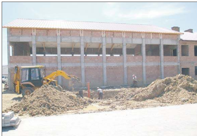
Budowa sali gimnastycznej w Głobikowej ma się zakończyć w 2017 roku.
