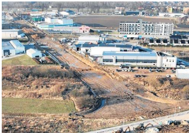
Na budowie obwodnicy Zatora rozpoczyna się kolejny etap inwestycji
