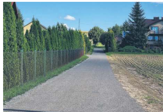
Droga do zabudowań w Krynichkach wybudowana przez gminną ekipę remontowo-budowlaną
