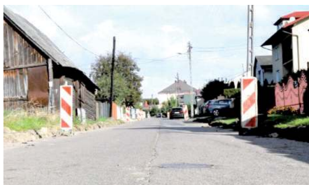
Remont ulicy Orzechowej we Frampolu już trwa
