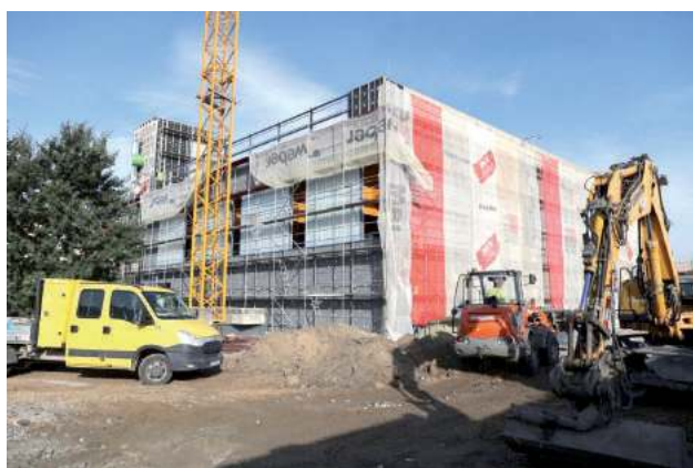
Końcowy efekt to obiekt o łącznej powierzchni użytkowej około 3 760 m 2 z powierzchnią lustra wody około 623 m 2 . Wartość obu etapów I i II szacowana jest na ponad 61 mln zł
