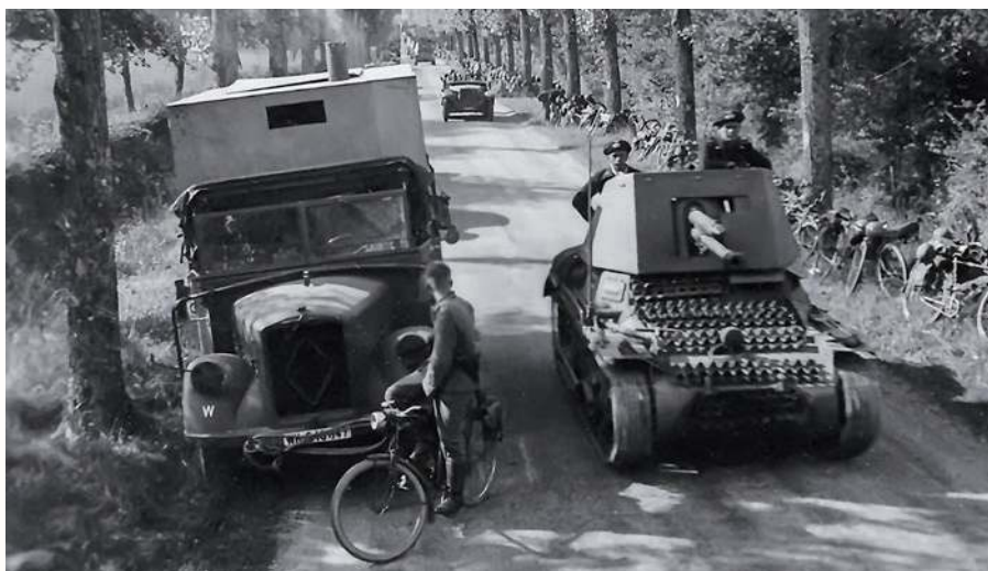
▲ Pierwszy niemiecki seryjnie budowany niszczyciel czołgów (Panzerjäger I) 4,7cm PaK(t) (Sfl) auf Panzer I Ausf B. Była to prowizoryczna konstrukcja utworzona przez ustawienie na pozbawionym wieży kadłubie czołgu Panzer I Ausf B czeskiej armaty przeciwpancernej 47 mm. Zbudowano łącznie 190 takich pojazdów dość skutecznych w walce z sowieckimi czołgami lekkimi.
