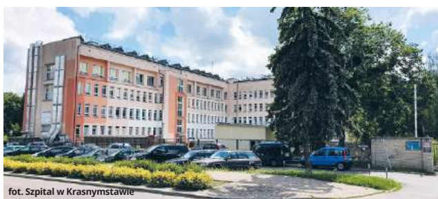
fot. Szpital w Krasnymstawie
