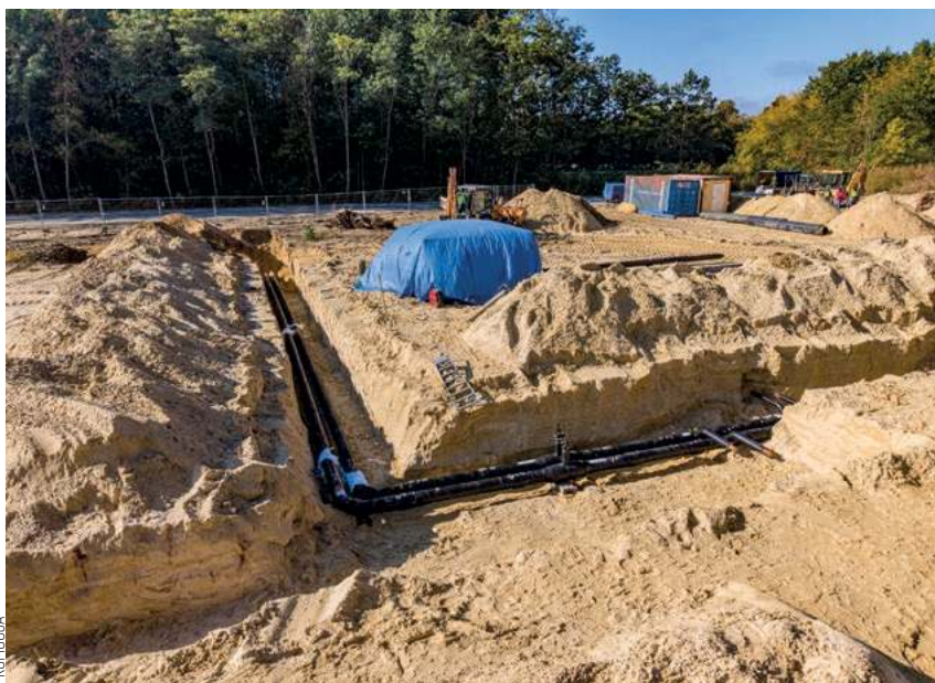
Zakres prac obejmuje budowę odcinka sieci kanalizacji sanitarnej, niezbędnej dla obsługi przyszłych budynków mieszkalnych
