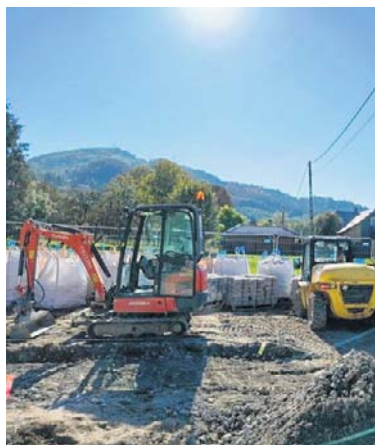
Trwa modernizacja, na placu budowy jest ciężki sprzęt
