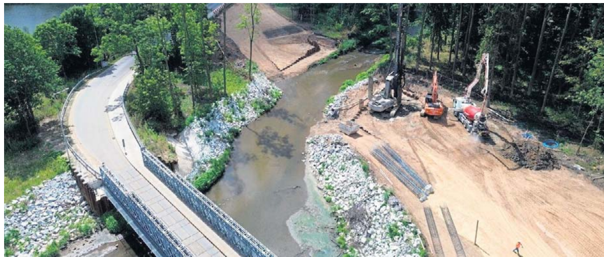
Budowa fundamentów pod przyczółki. Z lewej widoczna tymczasowa przeprawa
