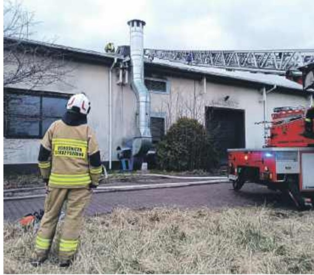
Strażacy pracujący na dachu hali
