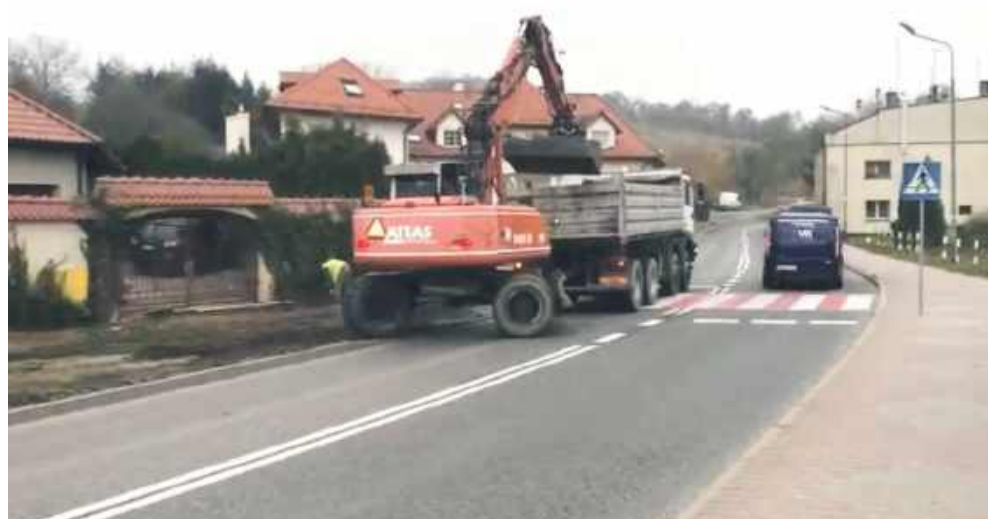
Budowa ścieżek rowerowych rok 2018
