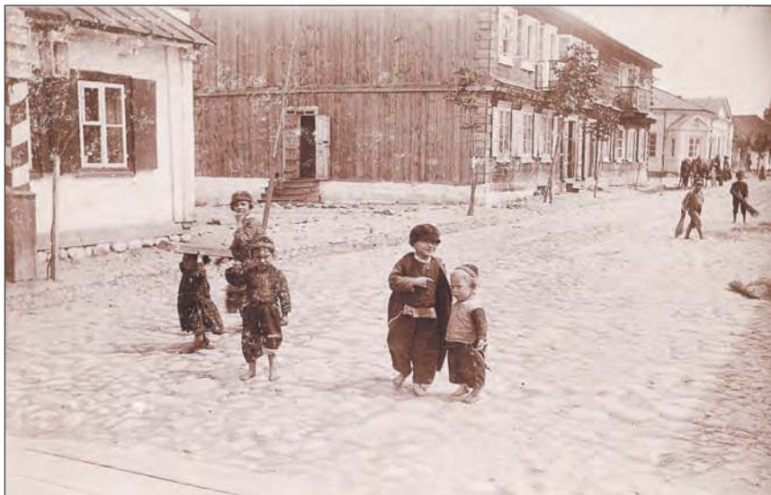
■ Restauracja stała w miejscu, gdzie dziś stoi różowy blok. Widać ją na zdjęciu Konrada Brandla (ten duży ciemny budynek).
