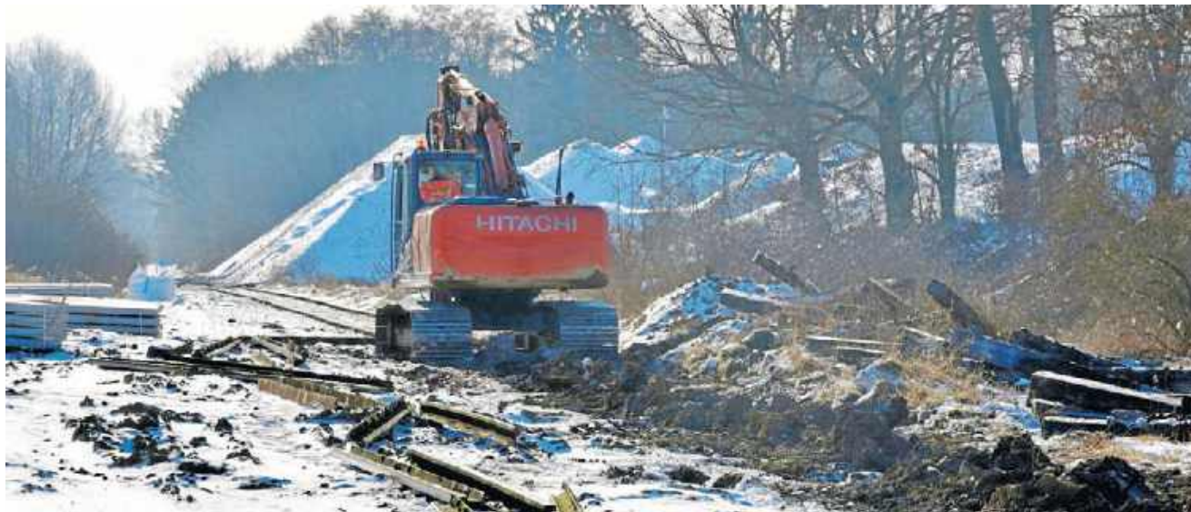
Rozbiórka torowiska przy stacji w Grylewie.
