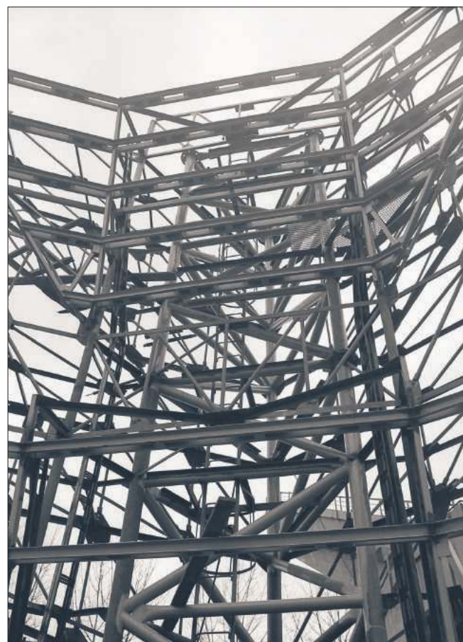
Jupiter w trakcie montażu.
