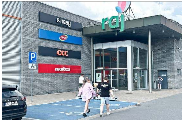
Nowy budynek sąsiadował będzie z galerią od jej południowej strony.
