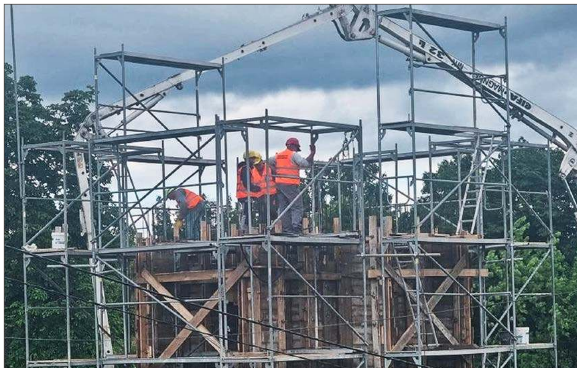
Prace przy budowie nowej dzwonnicy przy kościele w Czarnej są już bardzo zaawansowane.
