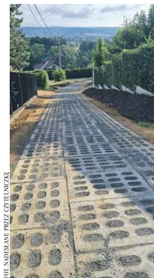
Ul. Głogowa w Tenczynku po remoncie
