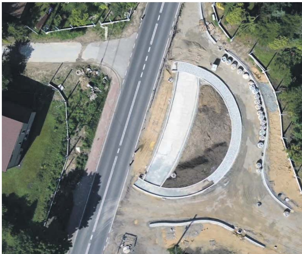
Powstaje rondo przy krajówce w Krzeszowicach
