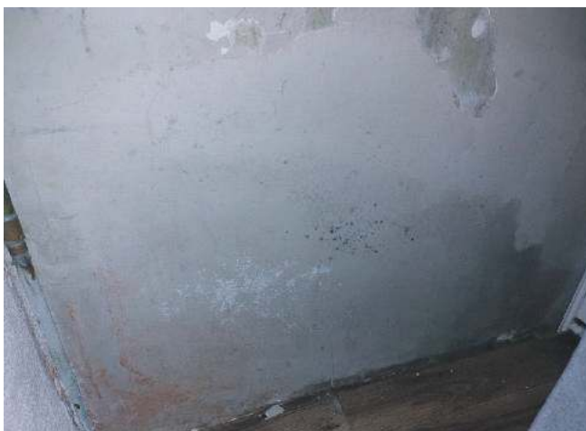
Ściana za łóżkiem
