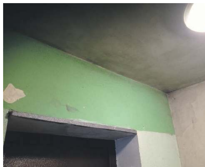
Sufit i ściany w przedpokoju
