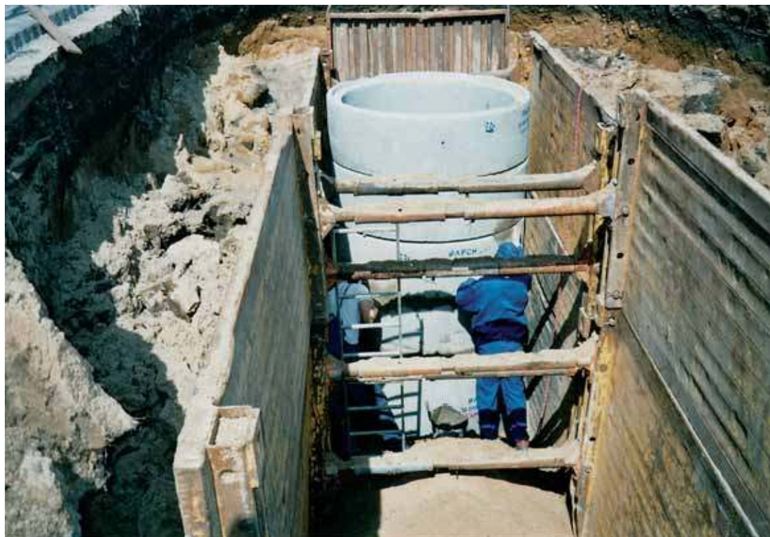
Kanalizacja deszczowa. Studnia i szalunek profili
