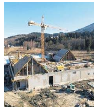
Budynek osiągnął już stan surowy
