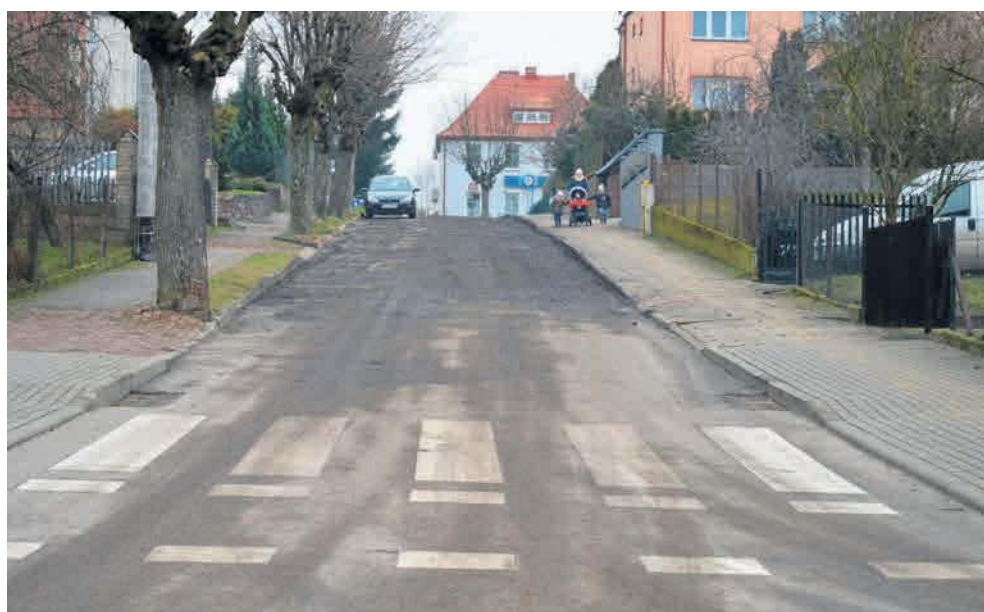
Ruszył remont ulicy Cichej w Bytowie
