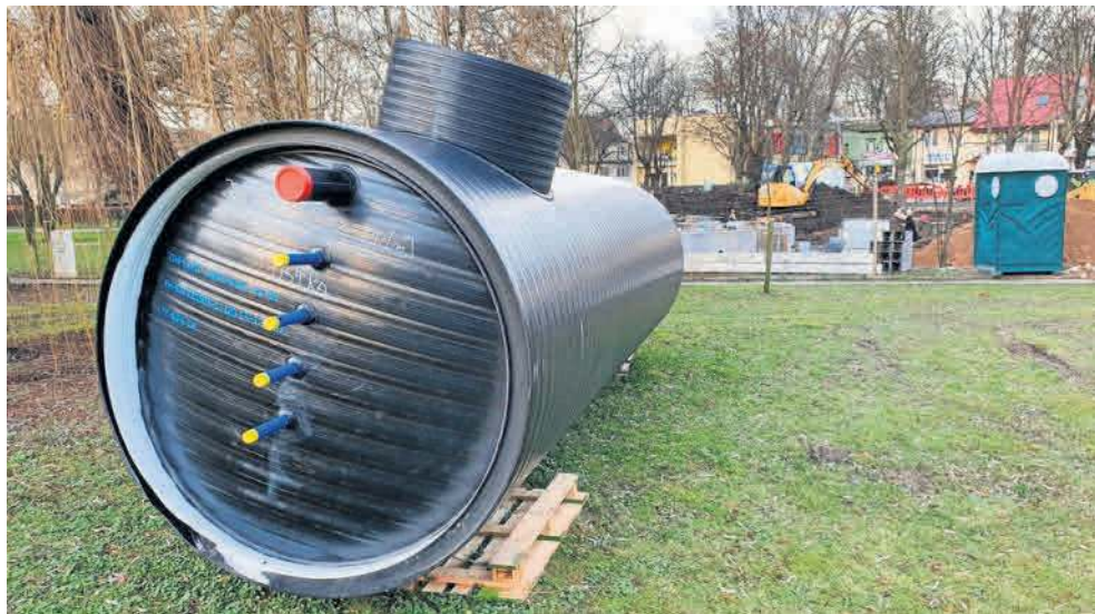
Na plac budowy tężni solankowej w Ustce przywieziono zbiorniki na solankę. Pod koniec marca leczniczy obiekt ma być gotowy, a później nastąpią kolejne etapy urządzania parku za kinem
