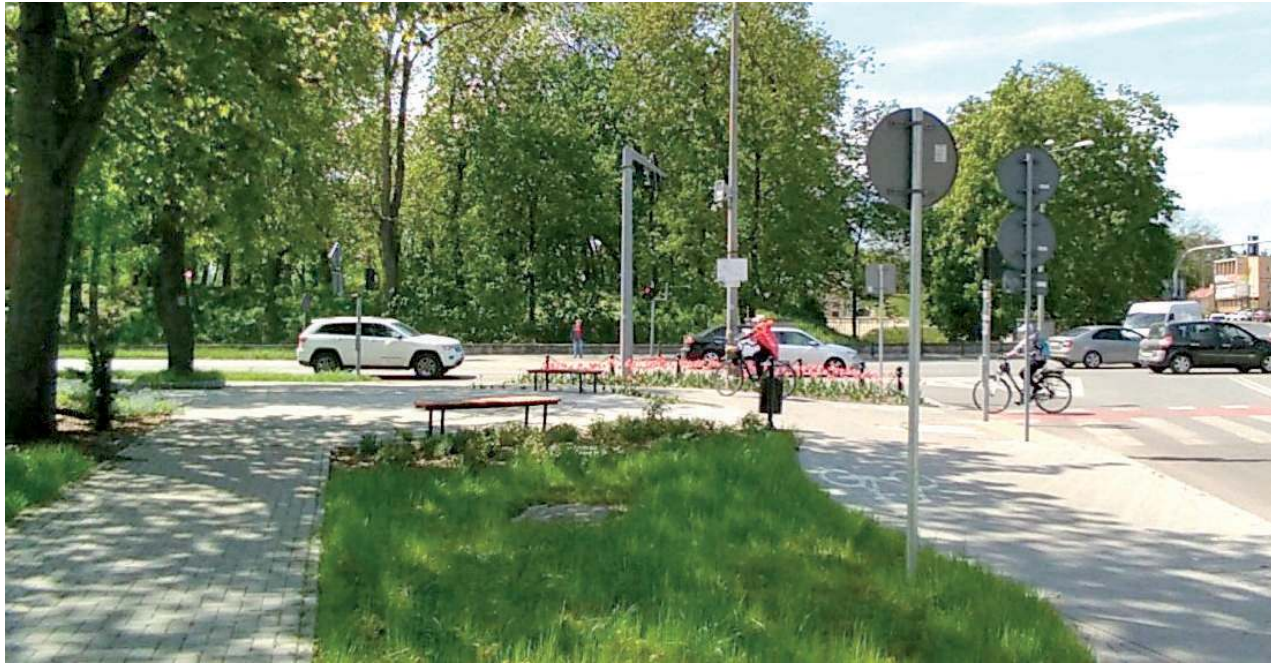
W minionym roku sfinalizowano przebudowę ścieżek rowerowych oraz skrzyżowania ul. Zamkowej z ul. Warszawską
