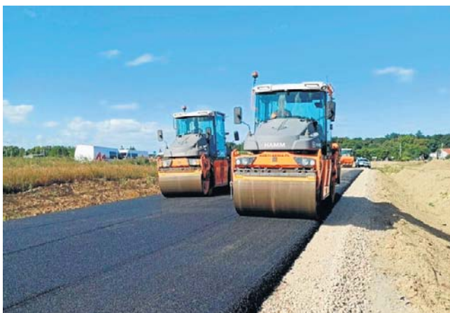
Budowa drogi z Redzikowa do Jezierzyc
