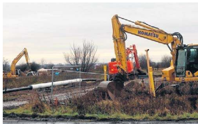
W rejonie ronda ruszyło zbrojenie terenów
