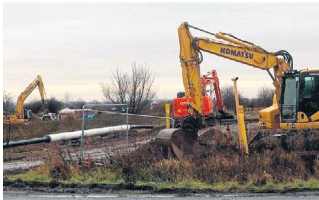
W rejonie ronda ruszyło zbrojenie terenów
