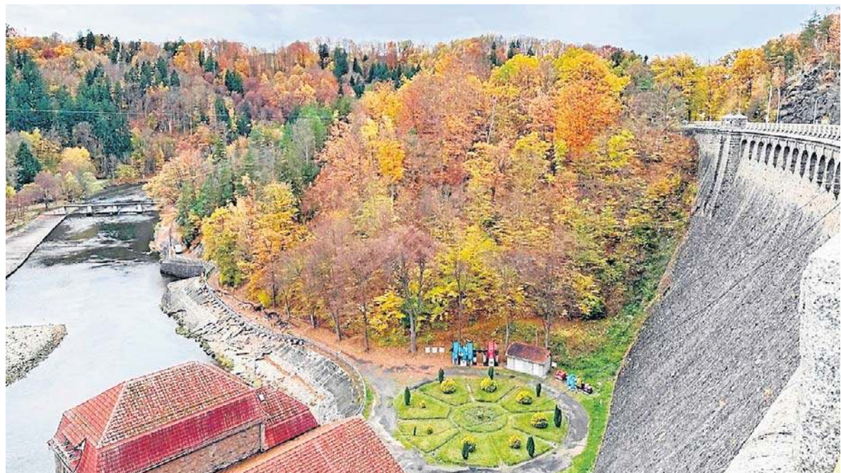
Podczas remontu, wiosną 2026 roku, po raz pierwszy od 50 lat spuszcza wodę z Jeziora Pilchowickiego
