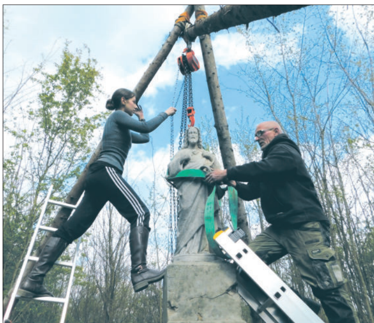
Prace prowadzono na przełomie kwietnia i maja.
