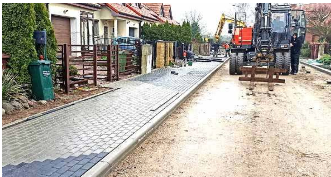
Trwa gruntowna przebudowa ulicy Chełmońskiego. Wykonano już chodnik z kostki betonowej
