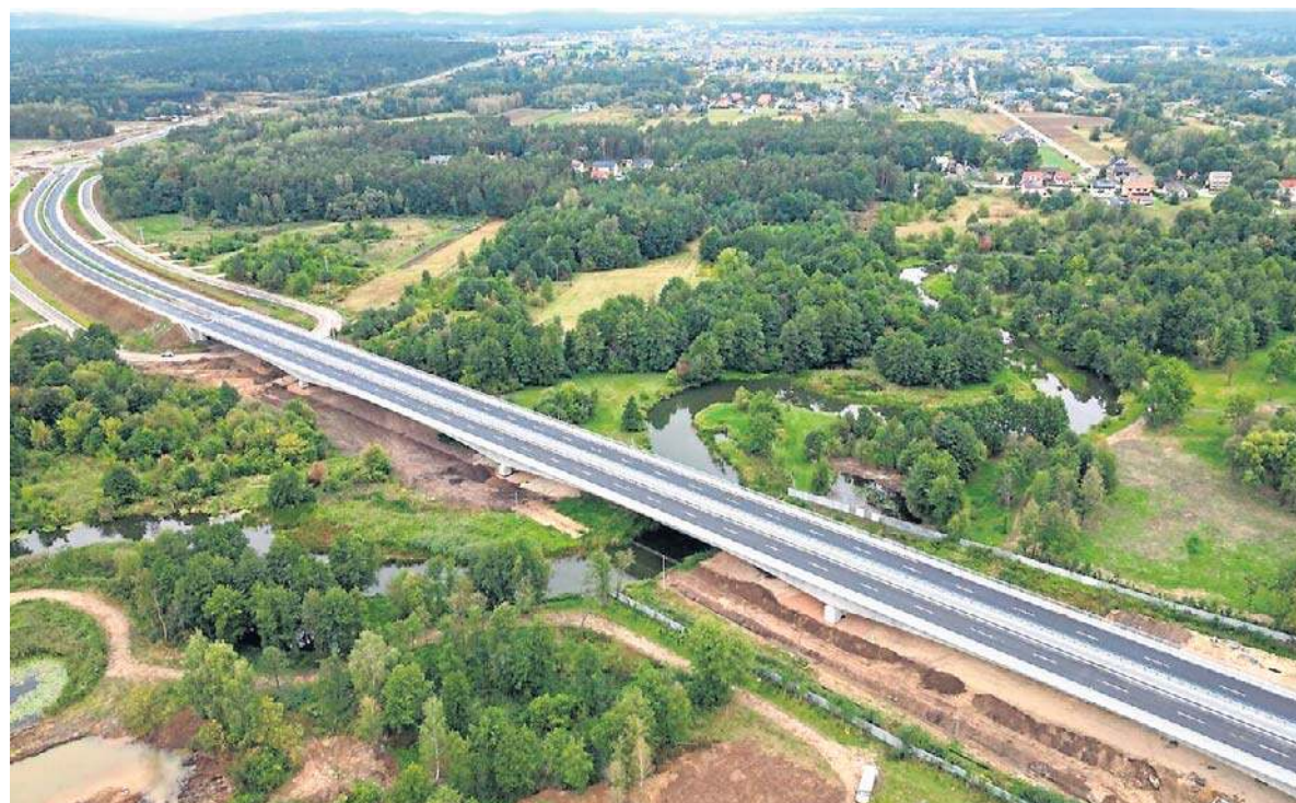
Trwają ostatnie prace przy oznakowaniu, poboczach i elementach bezpieczeństwa ruchu. Ogromne wrażenie robi najdłuższa w województwie estakada mająca blisko pół kilometra
