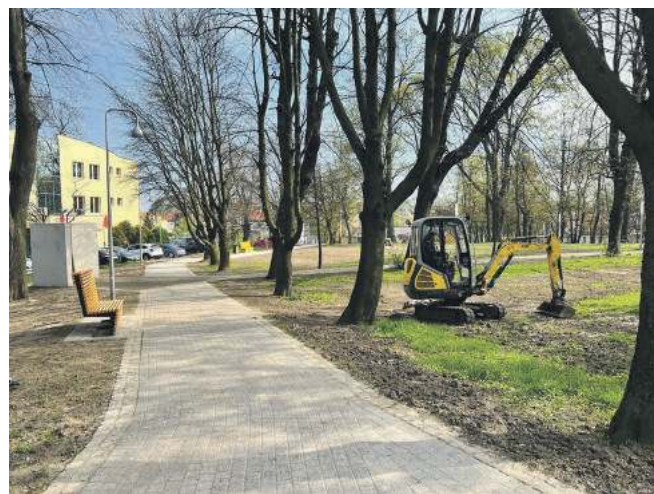
W piątek, 28 kwietnia prace jeszcze trwały
