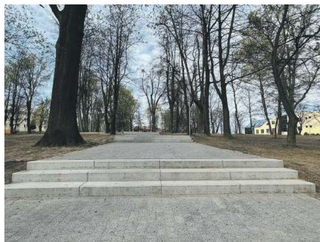
Przebudowane schody nie mają ani poręczy, ani podjazdów dla wózków
